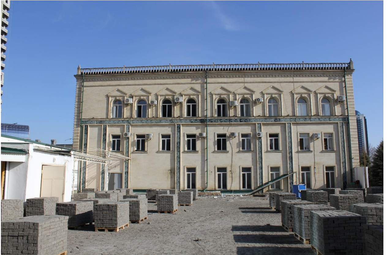
Фото 12. Северо-западный (торцевой) фасад Объекта.
