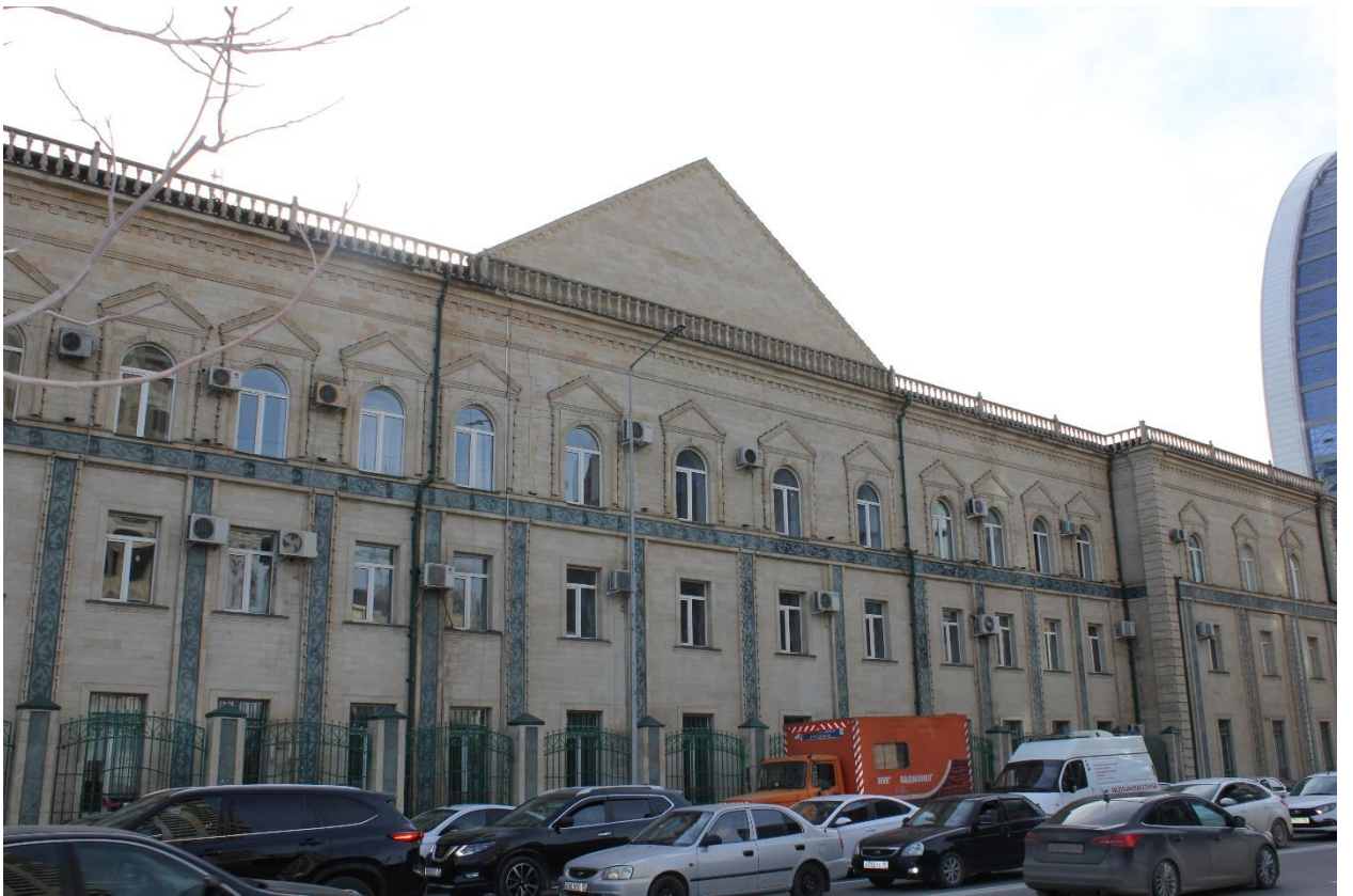
Фото 9. Фрагмент северо-восточного фасада, юго-восточный фасад (ризалит) и фрагмент северо-восточного фасада (ризалит) Объекта. Дата съемки: 28 марта 2024 года.
