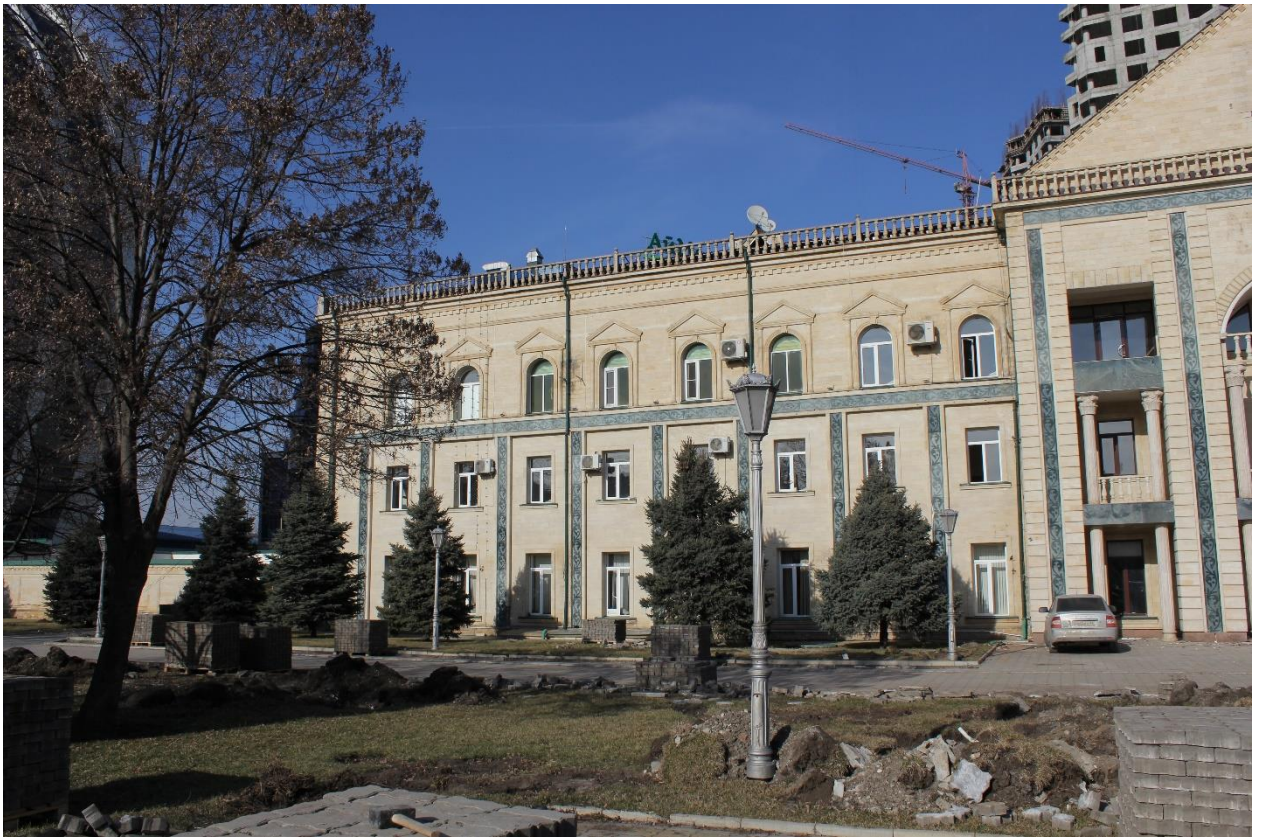
Фото 2. Юго-западный фасад и фрагмент юго-западного фасада (портик) Объекта.
