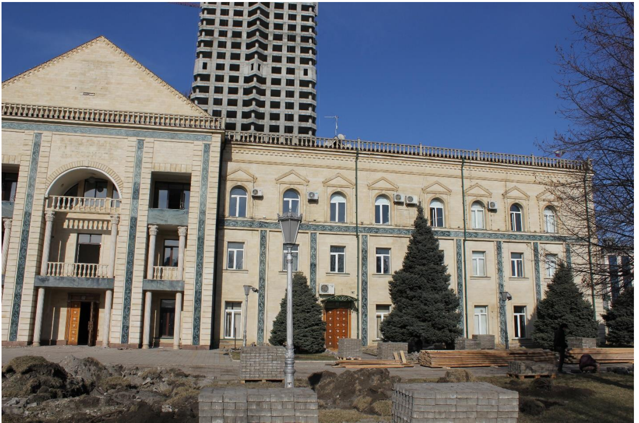
Фото 4. Фрагмент юго-западного фасада (портик) и юго-западный фасад Объекта.
